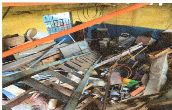
Foto 4: Situación actual del local de la cocina, donde se ejecutarán trabajos de remozamientos para habilitarla en condiciones adecuadas e higiénicas.
