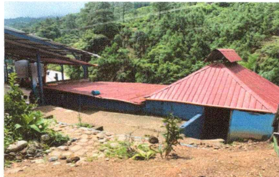
Foto 2: Panorama del modulo 2, una parte será intervenida con sustitución de láminas, además en la cocina se realizarán varios renglones de trabajos.
